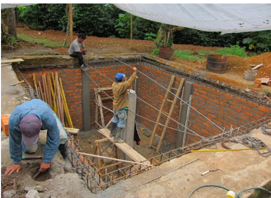
Unten: Bau einer Regenwasserzisterne auf der Finca.
